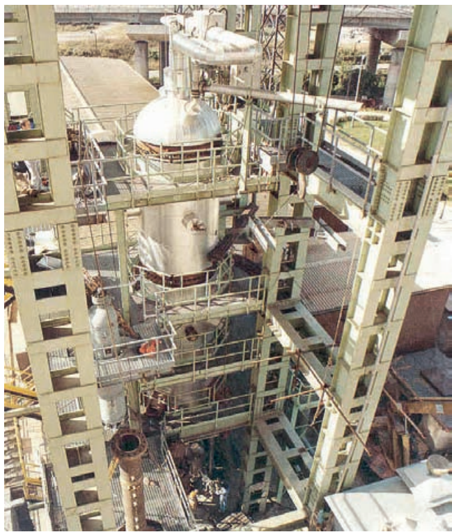
Figura 2 - Impianto GEST: vessel (volume 43 m 3 , altezza 15 metri)
