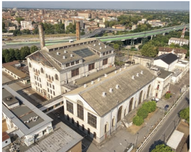
Figura 1 - Sede della SIET S.p.A all'interno della Ex Centrale Emilia
