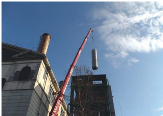
Figura 3 - Inserimento del generatore di vapore di NuScale Power all'interno del vessel del GEST
